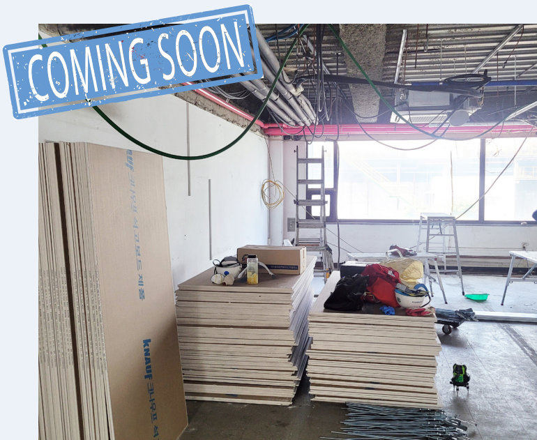
사전 공사 시작
